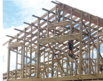
एक भवन निर्माण
